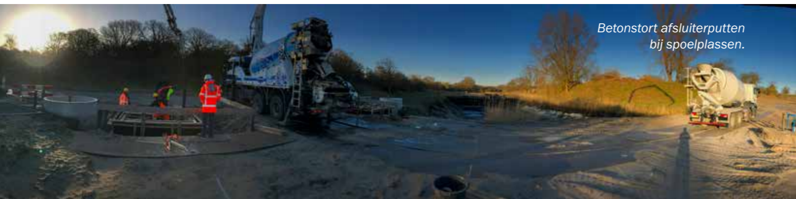
Aanleg bezinkbuffer.
